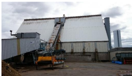
3. Az aprítót és az égető teret összekötő szállító szalag és aprító tér
