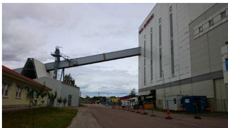
3. Az aprítót és az égető teret összekötő szállító szalag és aprító tér
